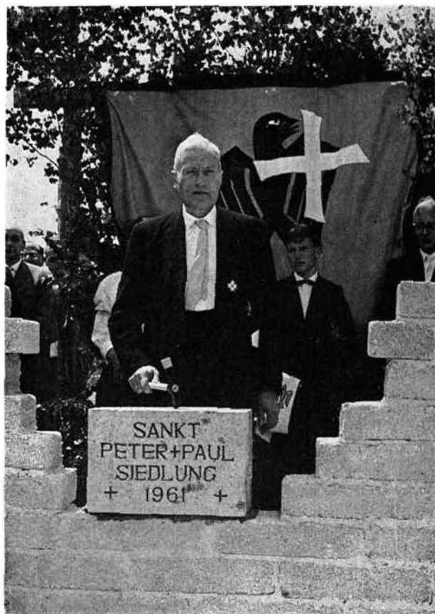
Der verstorbene Siedlervater Dr. Paul Dahm bei der Grundsteinlegung einer neuen Eigenheimsiedlung.
